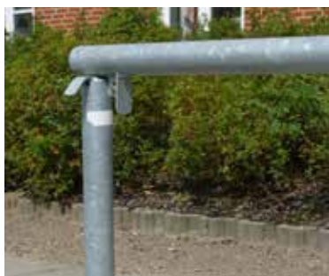
Aflæggerpost - ved åben stilling
