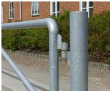
Hængsler er justerbare med smørenepler i top
