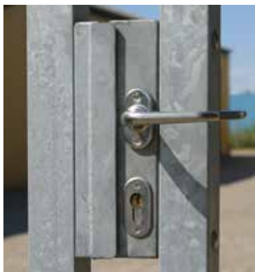
Låsekassen - monteret på rammen
