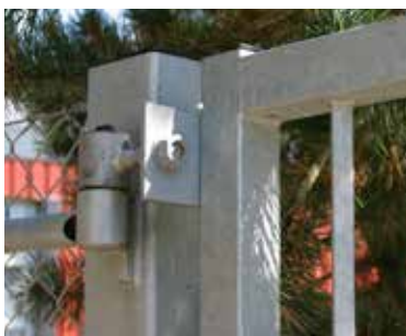
Justerbare hængsler påboltes
