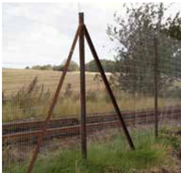
Skråstivere på hjørne-/strammestolper
