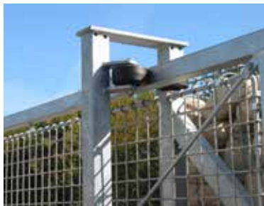
2 hjul fastholder portbladets bevægelse
