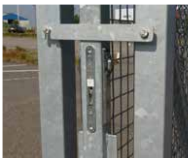
Indbygget lås samt beslag for fastholdelse af portblad i åben position.
