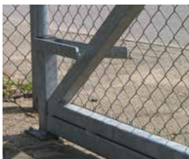
I åben stilling holdes porten på plads af bagstop
