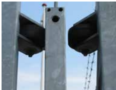
Støttehjul til fastholdelse af skydeport
